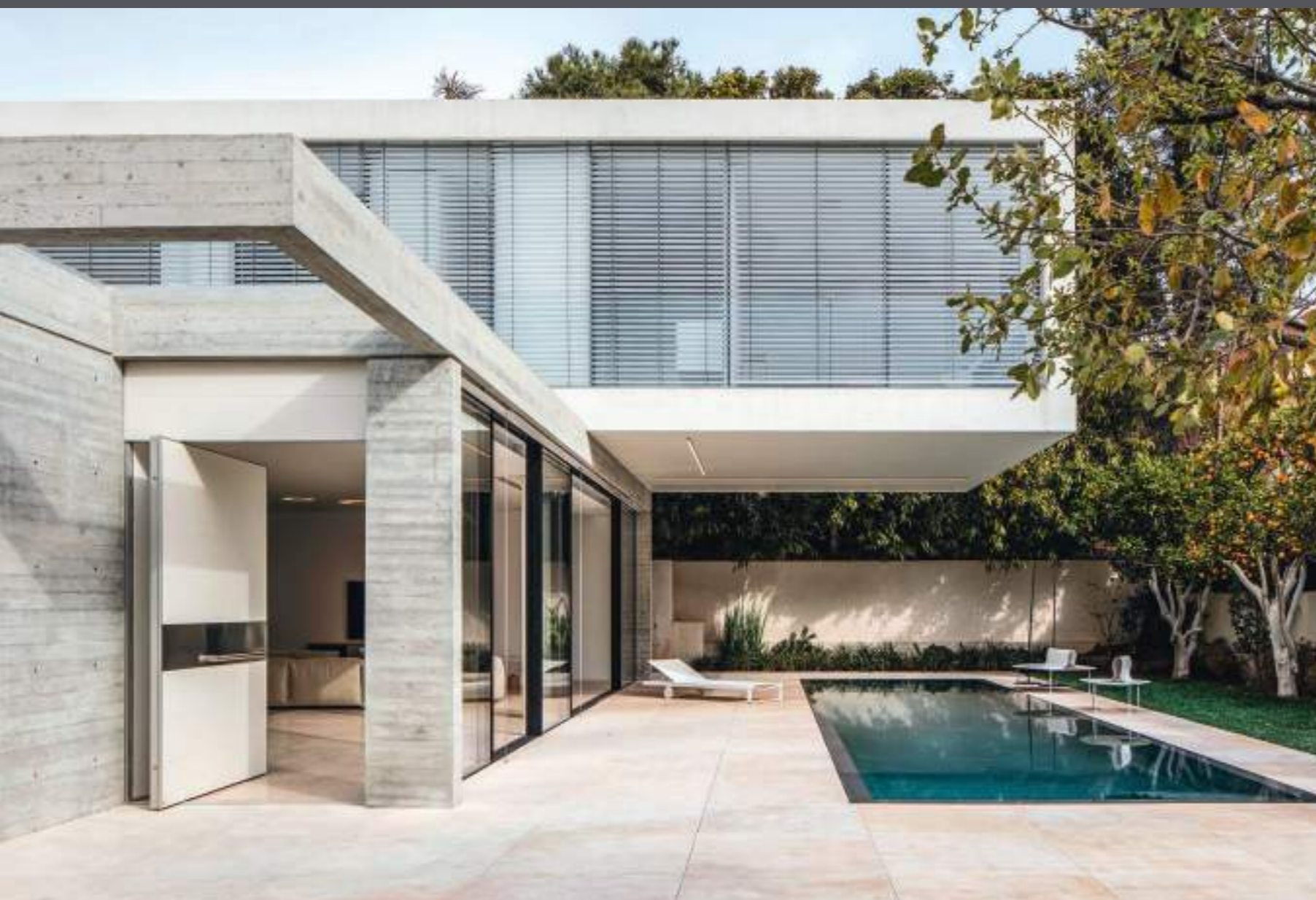
Esterno: Línea Portici a settori Laminam Neve con settore in Inox Montaggio a tutta altezza
