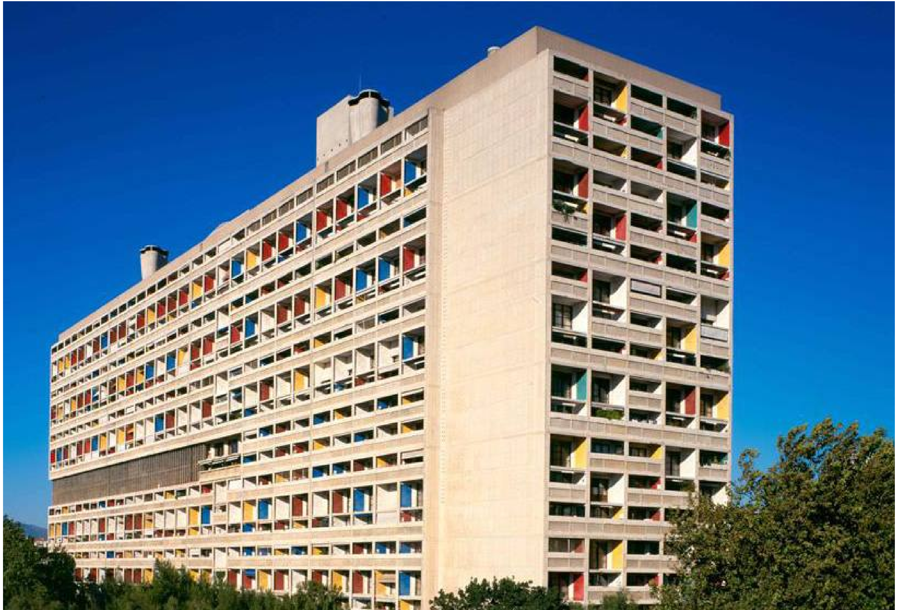
Unité d'Habitation Marseille, France 1945
